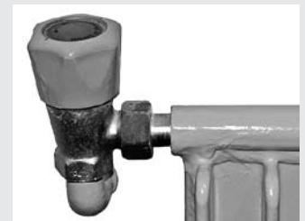
Alt: Handradiatorventil
